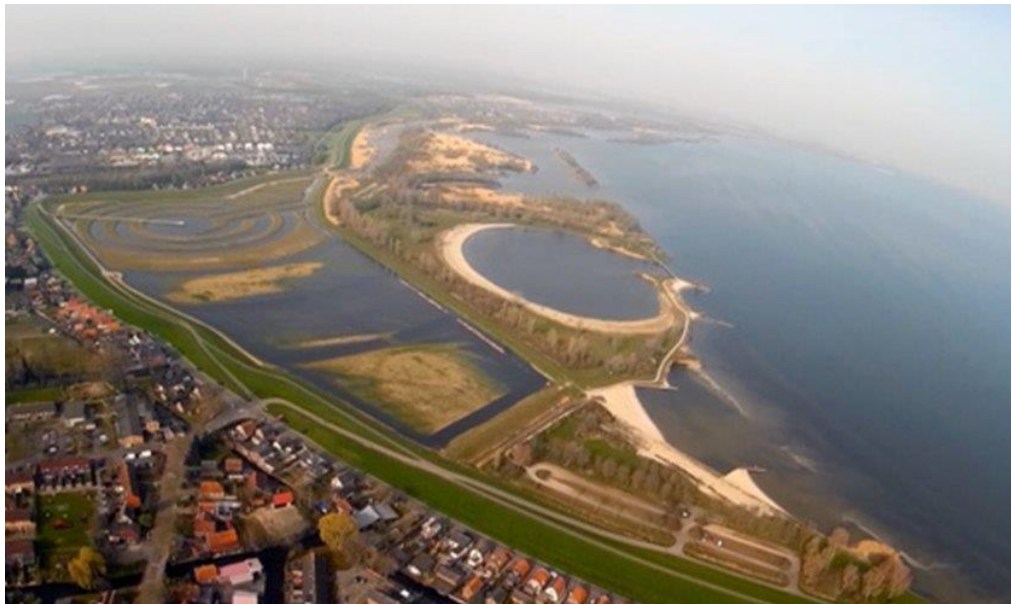
De Koopmanspolder bij Andijk (links). Rechts op de foto het IJsselmeer. De Koopmanspolder staat in verbinding met het IJsselmeer via een buisvijzel (foto Rijkswaterstaat).
